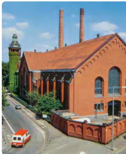
Die „Centralstation“ am Zugweg lieferte vor 125 Jahren erstmals Strom für Köln. In den denkmalgeschützten Mauern produziert das heutige Heizwerk Südstadt Fernwärme.
