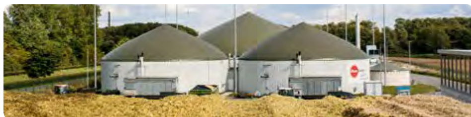
Nach der Modernisierung wird die Biogasanlage am Randkanal-Nord flexibler und wirtschaftlicher arbeiten können.
