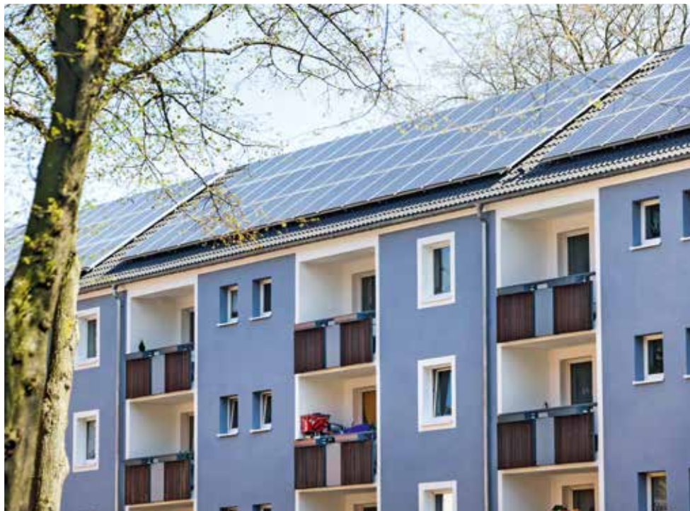
Wie sich eine bestehende Siedlung zukunftsfähig gestalten lässt, zeigt die Stegerwaldsiedlung in Köln-Mülheim: Im Rahmen des EU-Projekts „Grow Smarter“ wird das rund 70 Jahre alte Quartier energetisch saniert, Photovoltaik-Anlagen liefern Ökostrom für die Bewohner, Angebote zur E-Mobilität sowie Carsharing- und Bikesharing-Dienste entlasten den Verkehr.
