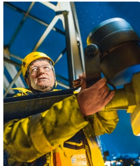
Ins beste Licht gerückt: Die Positionierung von LED-Strahlern ist Millimeterarbeit, wie hier an der Hohenzollernbrücke.
