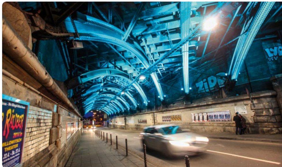
Im Projekt „Lichtpassagen“ gestalten wir gemeinsam mit der Stadt Köln Unterführungen und Tunnel mit Hilfe weißer und teilweise farbiger LEDs um. Bisher unzureichend beleuchtete Stadträume machen wir für die Bürger so attraktiver und sicherer.
