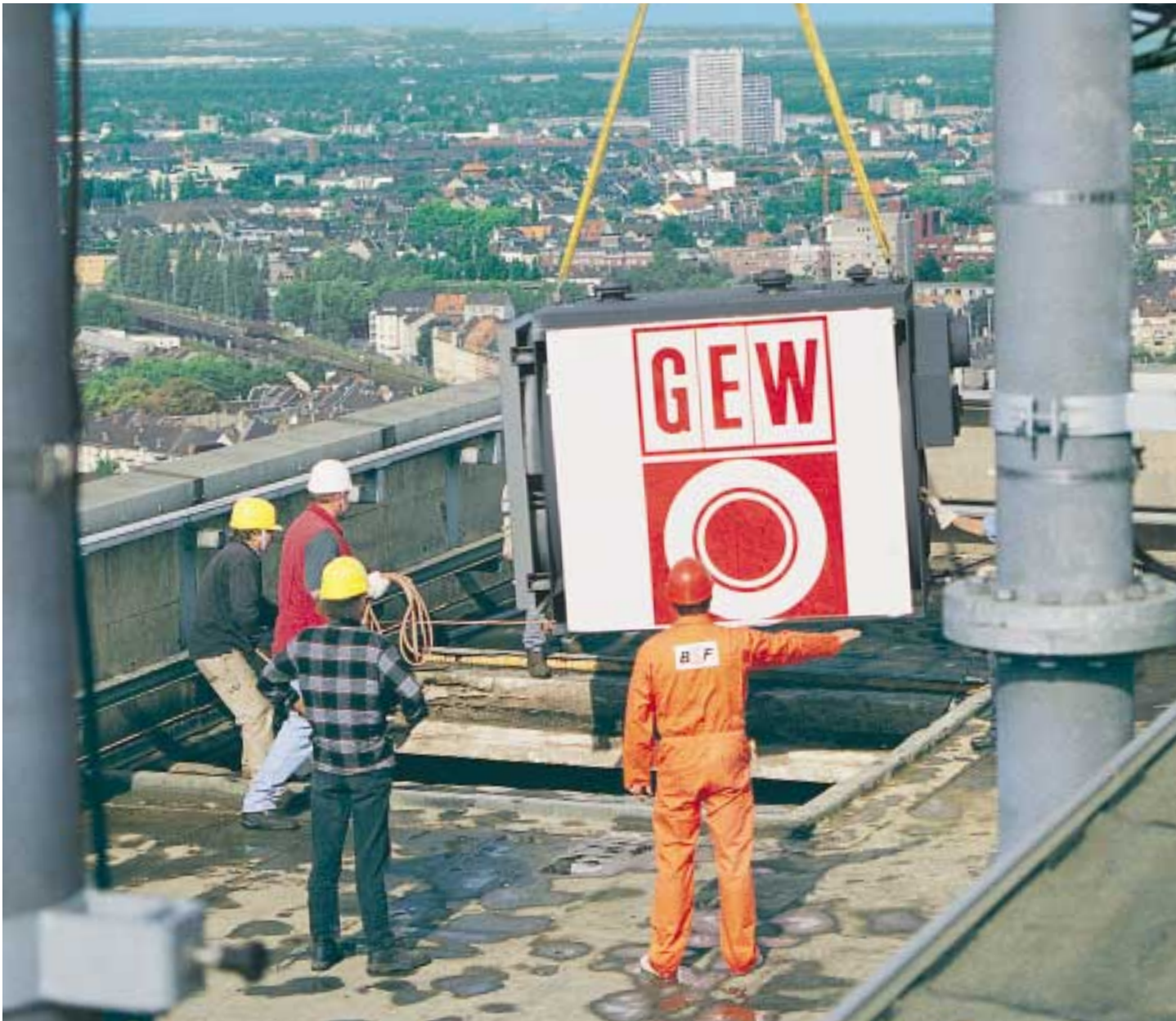
Auf dem Dach des Herkules-Hochhauses in Köln-Ehrenfeld setzt ein Hubschrauber in 90 Meter Höhe einen Heizkessel zur Montage ab.
