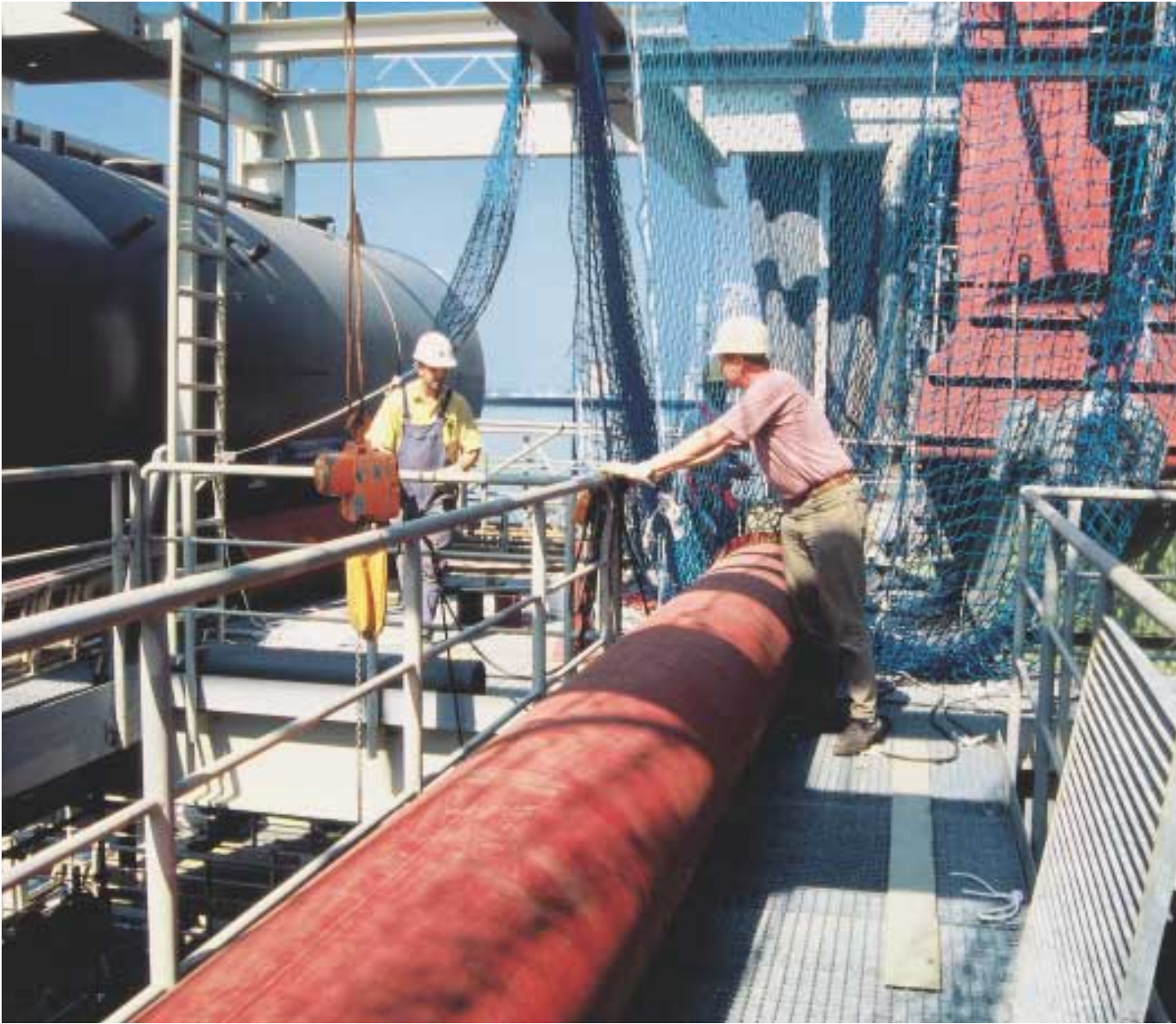
Die Montagearbeiten für die neue GuD-Anlage gingen zügig voran.
