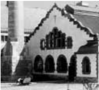
Außengiebel des Kesselhauses im Wasserwerk Hochkirchen, das 1905 nach dreijähriger Bauzeit seinen Betrieb aufnahm.
