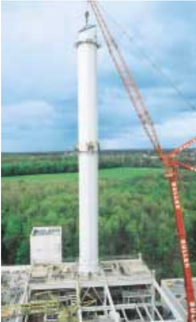
In schwindelnder Höhe wird der Schornstein der neuen GuD-Anlage montiert.
