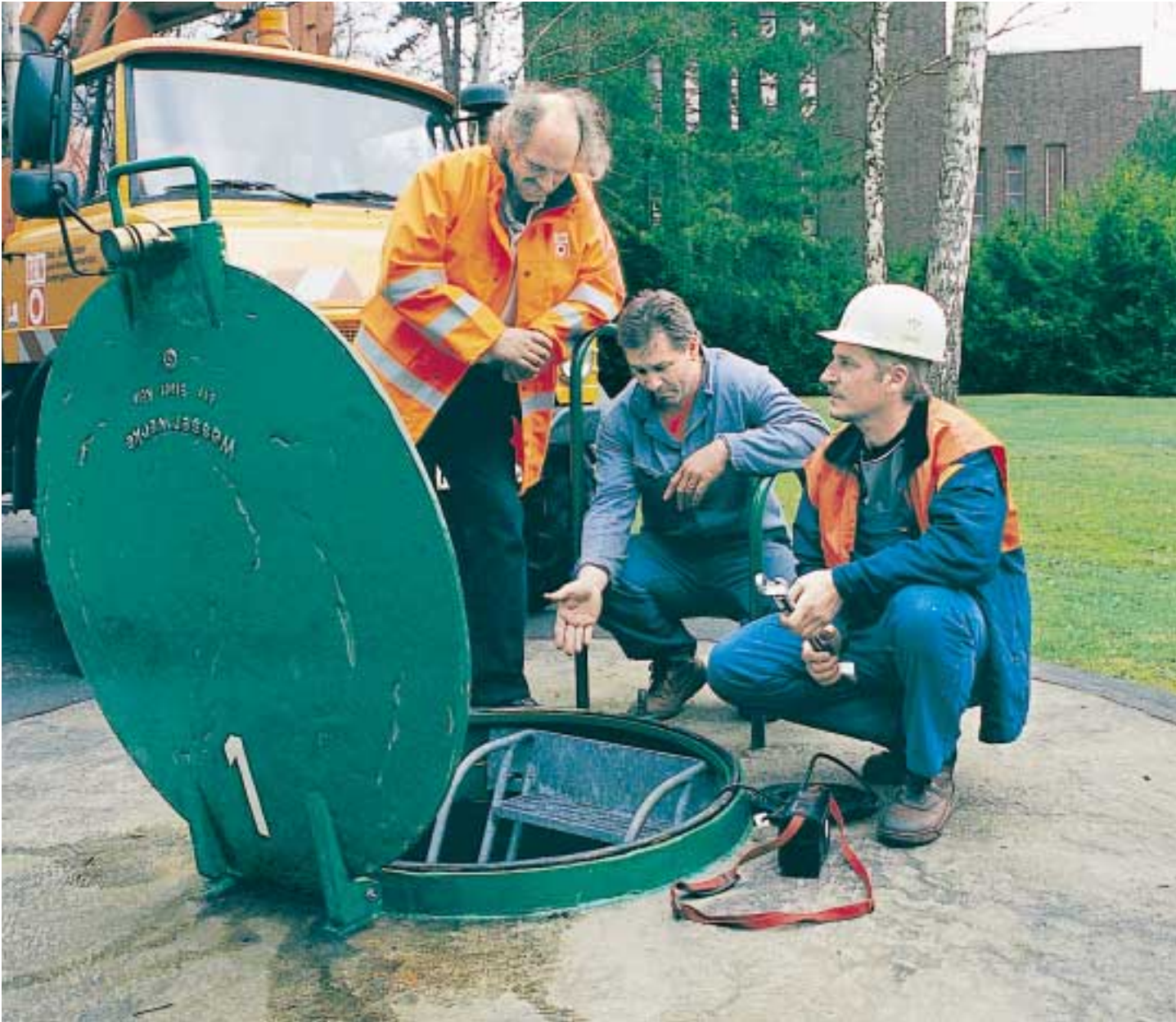
Inspektionen geben Aufschluss über den Zustand der Grundwasserbrunnen.
