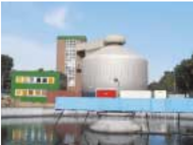
Im Klärwerk Köln-Rodenkirchen wurde die Brennstoffzellenanlage errichtet.
