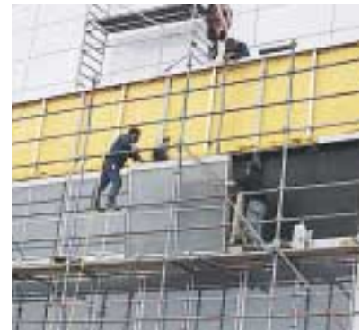
Die TWD-Elemente wurden in die Außenwand des Laborgebäudes integriert.
