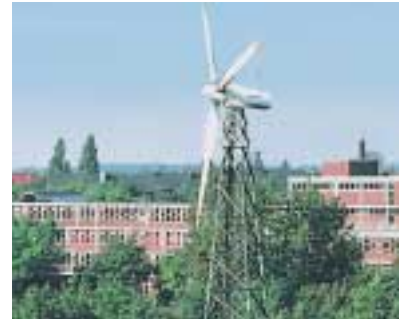
Seit mehr als zehn Jahren sammelt man Erfahrungen mit der Windenergie.
