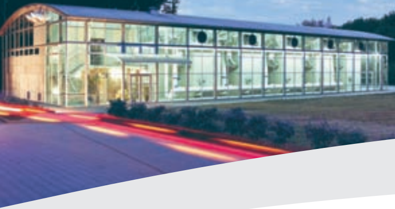
Die Filterhalle des Wasserwerks Westhoven in der Abenddämmerung
